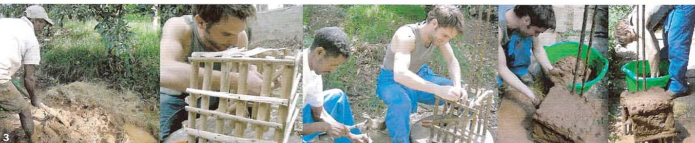
林，整個過程都無使用化學的材料。製作時以電腦做精準的切割，以便之後無須使用任何工具，以接榫的方式直接組裝。拆解後可全部收納進推車中，方便搬運。
